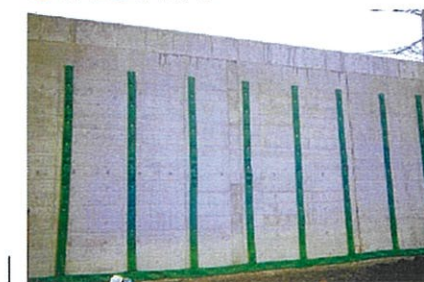
② 擁壁裏面排水
