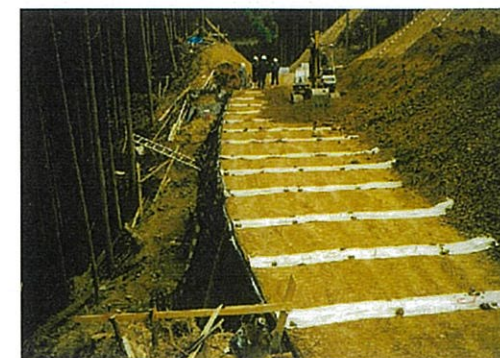
盛土内排水（盛土補強材併用）
