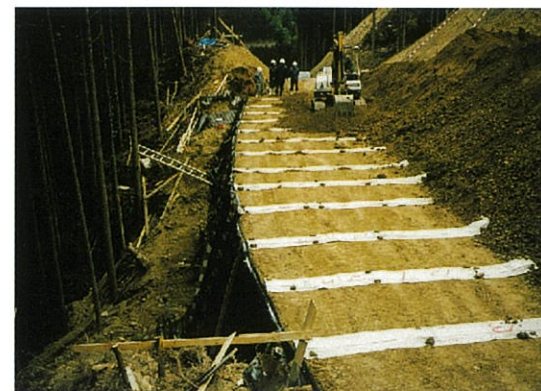
盛土内排水（盛土補強材併用）
