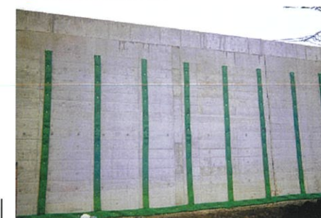
② 擁壁裏面排水
